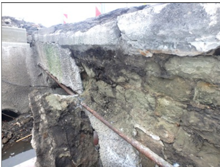
Dtto, detail - rozpad zdiva, separace torkretu v celé délce, uvolněné bloky římsy
